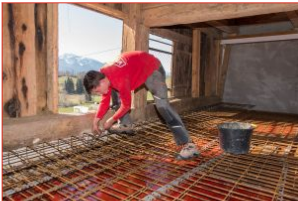
Die Eisengitter werden befestigt
